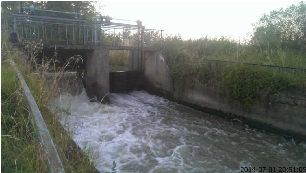
Przykładowe zdjęcie z inwentaryzacji terenowej (jaz na rzece Nidzica)
